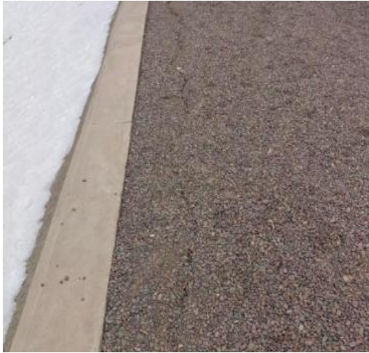
坝顶裂缝
