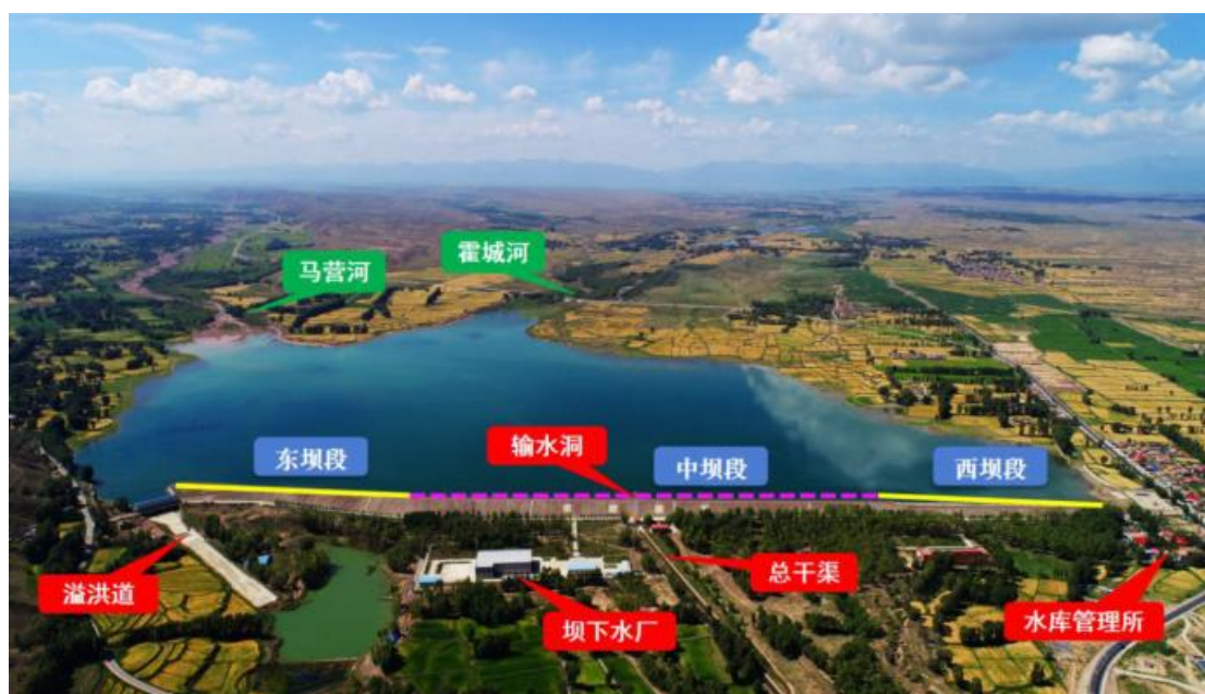
图 2.1-2 水库枢纽全貌
